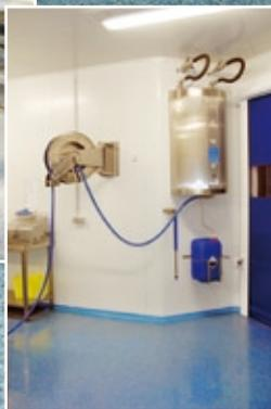
**DESCRIPCIÓN:** Pavimento multicapa continuo formado por mezcla de resinas sintéticas exentas de disolventes y árido natural de cuarzo con espesor medio de 4 mm, aplicado a llana en varias fases con acabados decorativos y antideslizantes.
